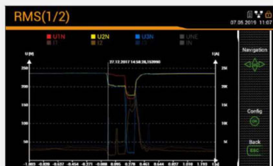
Spadek napięcia wyświetlany na lokalnym wyświetlaczu
