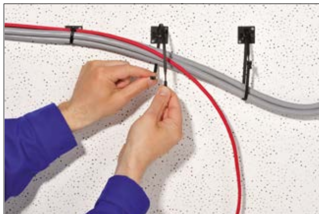
Opaski serii Q można stosować zarówno do czasowego, jak i stałego wiązania przewodów.
