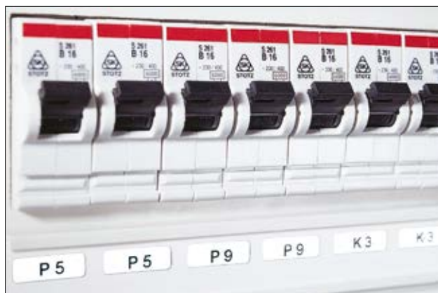
Jednoznaczne i trwałe oznaczenie aparatury modułowej.
