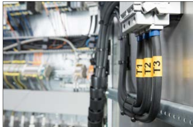
Oznaczniki termokurczliwe TLFD DS - bezpieczne i przejrzyste oznakowanie szaf rozdzielczych.
