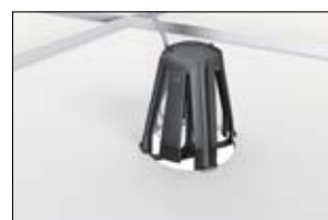
2. Wciśnij stopki w płytę gipsowo-kartonową, aby zapobiec przesunięciu i odłącz narzędzie.
