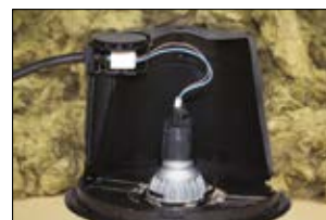
Przekrój rozpórki mocującej SpotClip-Box.
