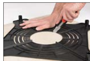
Użyj SpotClip-Plate jako szablonu do wycięcia otworu w płycie podsufitowej.
